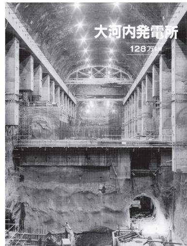
図11 関西電力(株)大河内発電所の地下発電所空洞(関西電力のパンフレットより引用)
