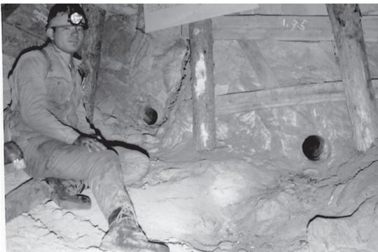
図2 幌内炭鉱地下1055mの山はね発生個所の地圧測定現場で撮影(1978)
