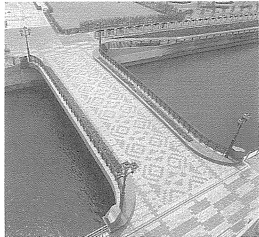
写真4 セラミックタイルを敷いた歩道橋 (福岡市)
